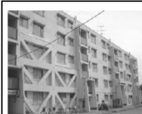
共同住宅 (外付けフレーム補強)
